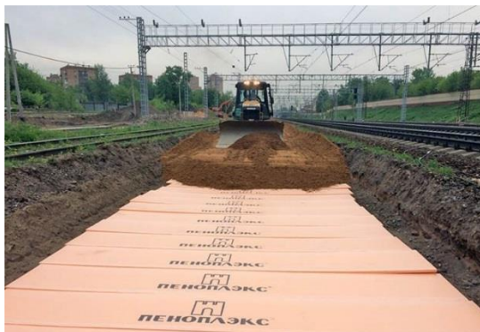
Рисунок 1 – Укладка утеплителя пеноплекс
